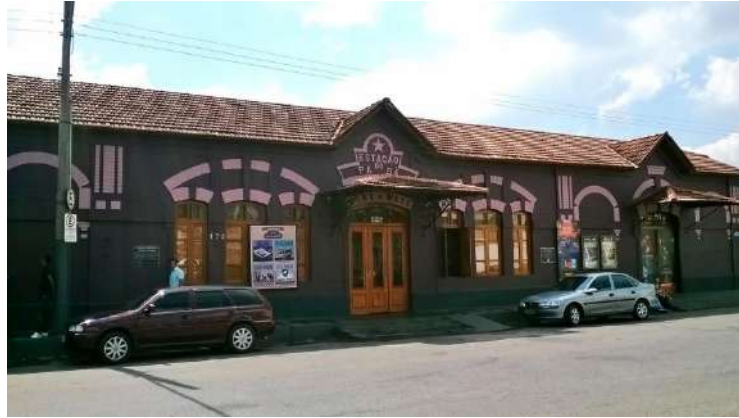
Estação Ferroviária Imagem da Internet
